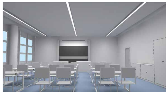
Salle de classe avec 3 x 8 luminaires LED
