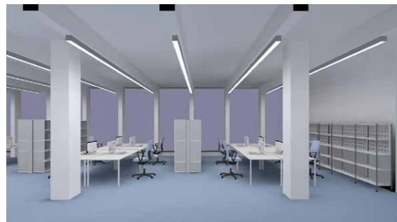
Open-Space avec 8 x 6 luminaires LED
