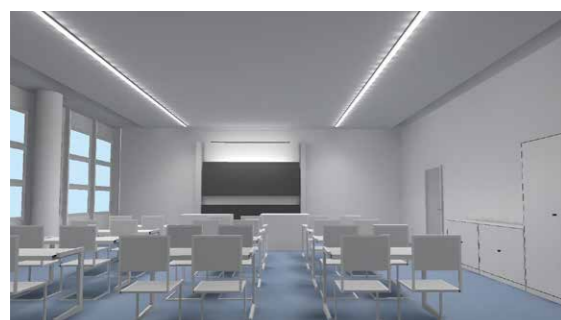
Salle de classe avec 2 x 8,5 luminaires Purelite C-LED
